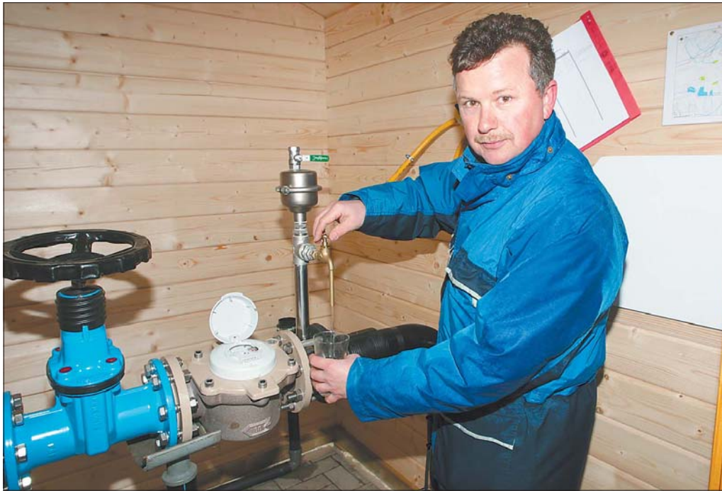
Wassermeister Edmund Brock füllt eine Probe in ein Glas ab. Für die chemische Untersuchung der Proben ist der städtische Betrieb aber nicht zuständig, das macht ein Untersuchungslabor, denn es ist sehr viel Sorgfalt erforderlich, um die Untersuchungsergebnisse nicht zu verfälschen.
